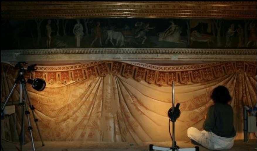
05c. Ricostruzione del partito decorativo mancante
